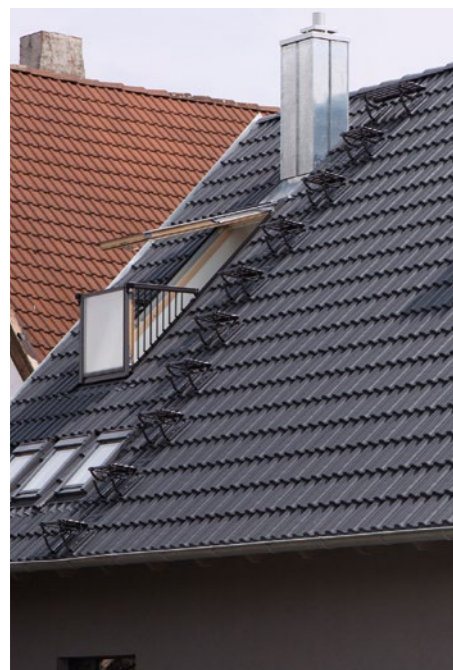
Dachówka ze strzemieniem pod ławę kominiarską
